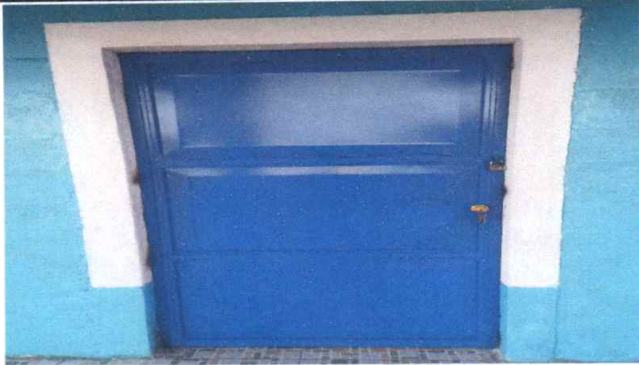
Foto1: Puerta de metal instalada
