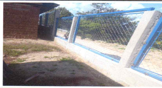
Foto 5: Muro perimetral reparado
